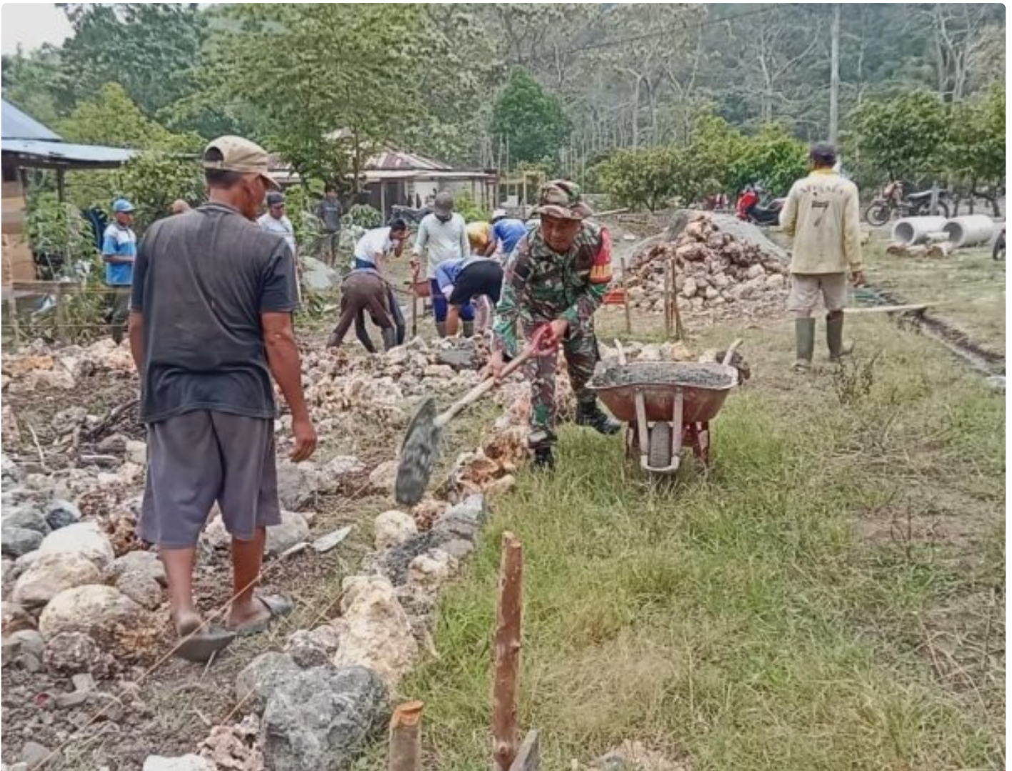
Gotong royong bangun pondasi rumah warga
